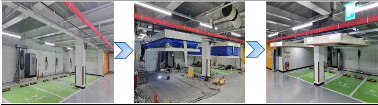
공영주차장 설치 현황
