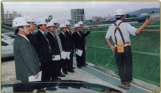
주택건축 공사현장 방문 중앙하이츠 주택 건축현장을 방문 집중 호우시 외부에서 유입되는 우수 방지를 위한 안전한 흙막이 장치를 마련하고 배수로 및 안전철편 설치와 모래주머니 설치 등 수해대책에 관하여 공사 관계자로부터 의견을 청취하는 수해대책특별위원회위원
