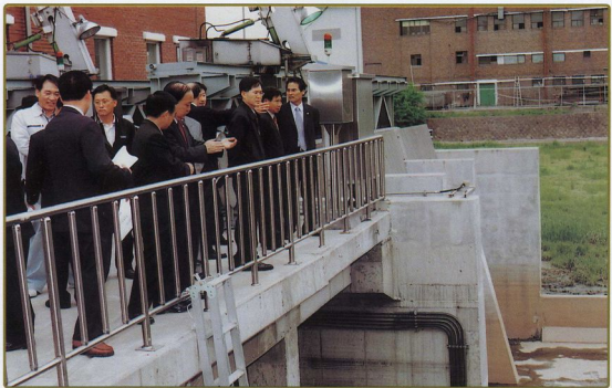
빗물펌프장 점검 가산2빗물펌프장의 펌프가동 기준 수위 도달시 펌프가동여부 등 수방시설물 정상 기능유지 여부를 점검하고 기상특보 발령시 빗물펌프장 근무자의 조치사항 등에 대하여 점검하는 수해대책특별위원회
