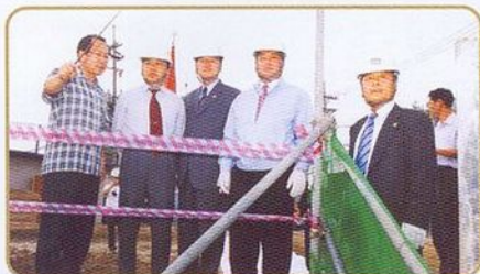
◎ 시흥본동 다목적광장 조성 공사장 (2005. 8. 26)
